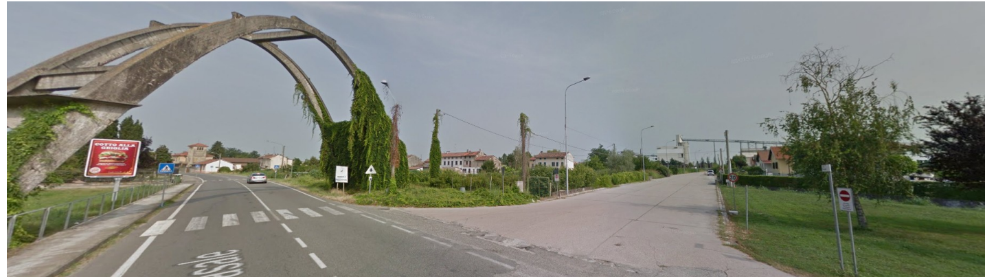
Vedute da Street view che inquadrano la viabilità realizzata rispettivamente da Via Casale e da Via Balzola
