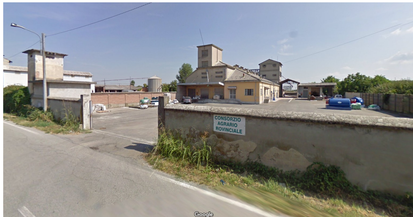
Veduta da Street View dell'area di modifica da Via della Stazione
