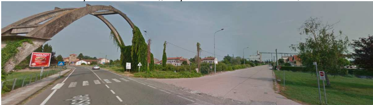
Vedute da Street view che inquadrano la viabilità realizzata rispettivamente da Via Casale e da Via Balzola
